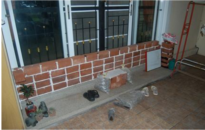
ภาพที่ 2.3 การก่ออิฐเพื่อป้องกันน้ำเข้าบ้าน ที่มา: http://www.eit.or.th
