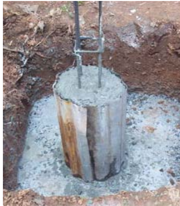
ภาพที่ 5.25 การใช้บัพสังกะสีเป็นแบบหล่อคอนกรีตๆ
