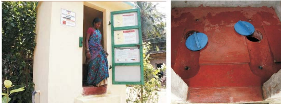
ภาพที่ 2.11 สภาพภายนอกและภายในส้วมแบบ Eco San ประเทศอินเดีย
